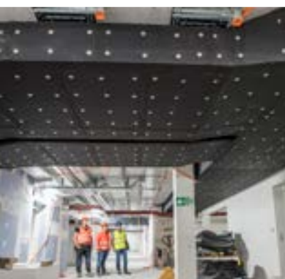
Zwei nebeneinander geführte Erschliessungskanäle mit Brandschutzdämmung im Untergeschoss
