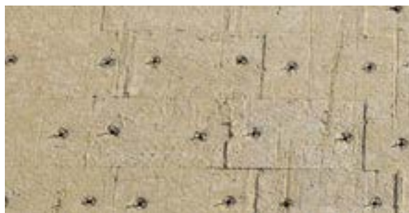
Oberes Bild: Flumroc-Dämmplatte DUO im Juni 2018, neu montiert an einer der Witterung ausgesetzten Fassade
