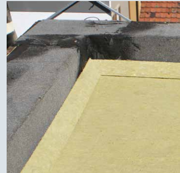
La cale triangulaire contre l'acrotère assure un raccord parfait, évitant toute accumulation d'eau.
