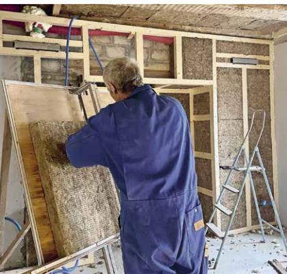
Les panneaux isolants Flumroc ont tout simplement été adaptés sur place.
