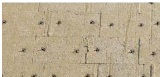
En haut: Les panneaux isolants DUO de Flumroc en juin 2018, montés sur une façade exposée aux intempéries.
