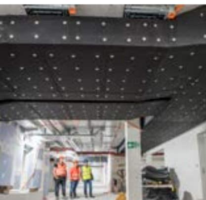
Deux canaux de raccordement côte à côte avec isolation de protection incendie au sous-sol.
