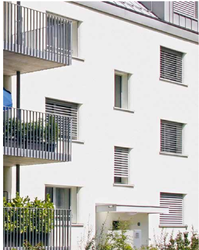
Après: Assainissement avec le système de façades POLYROC
