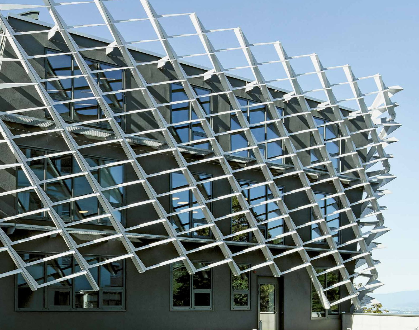
«La façade du pôle AGORA de recherche sur le cancer à Lausanne présente une valeur de luminosité (Y) de 12.39.»
