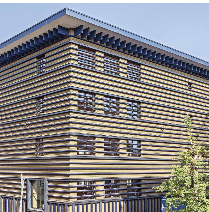
Il nuovo edificio in legno a sei piani si erge nel centro di Sursee.
