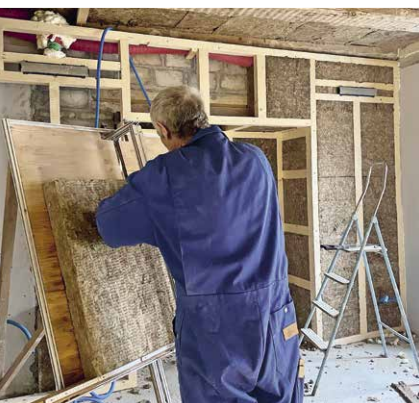
I pannelli isolanti Flumroc hanno potuto essere adattati senza difficoltà sul posto.
