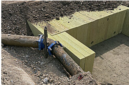
Éléments en laine de roche pour la rétention à court ou à long terme des eaux pluviales.
