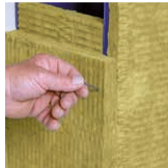
Fixation du revêtement anti-feu au moyen d'agrafes en acier en attendant le séchage de la colle (jusqu'à 12 heures)
