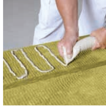
Application de la colle Conlit® sur le revêtement (en serpentins)
