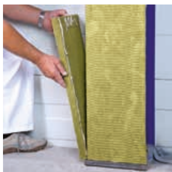
Applicazione del rivestimento antincendio sulla flangia laterale
