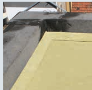
Il cuneo per tetto garantisce una rifinitura perfetta senza ristagni d'acqua.
